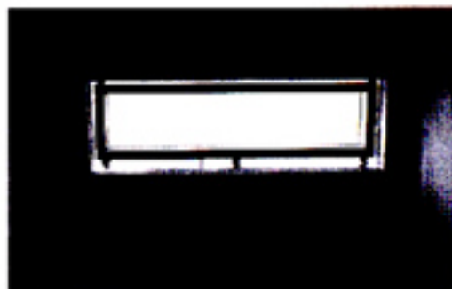
Vinduesplacering i bagmurs- element. Tolerance- problemer i pre-fabrikerede vindueshuller
