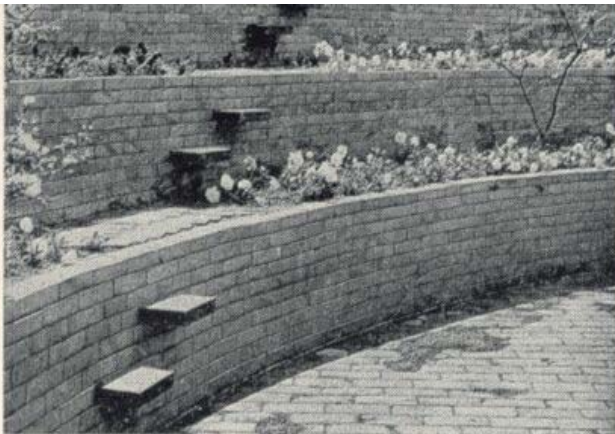
Aftrappede støttemure med indstukne betontrin
