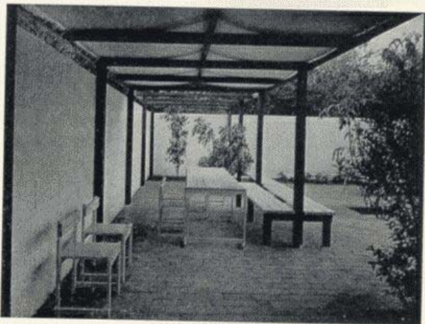
Overdækket udekøkken med ildsted
