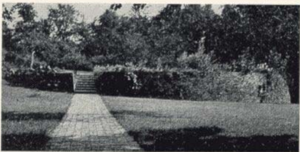
Støttemur med indbygget trappe
