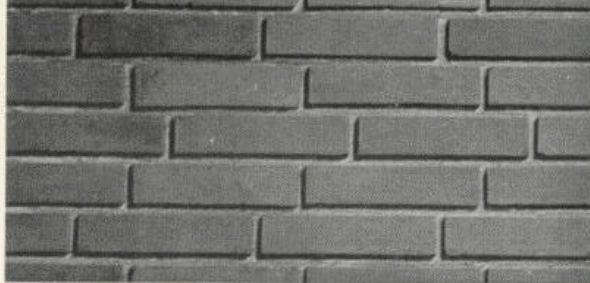
Løberforbandt med \frac{1}{4} stens spring, maskinstrøgne sten
