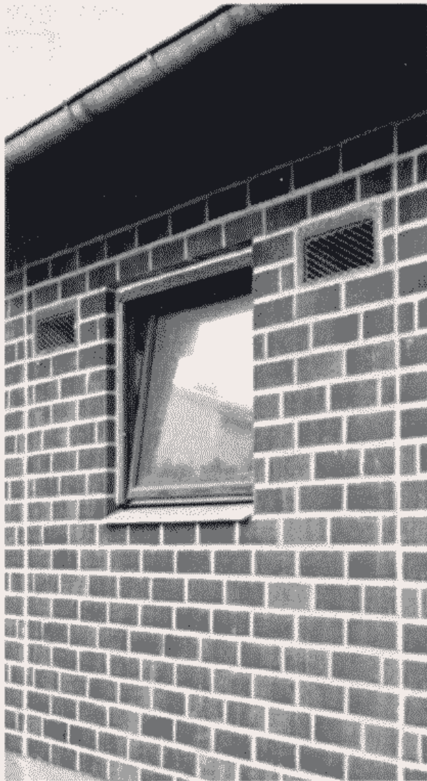
De lodrette fuger imellem de enkelte teglelementer ses tydeligt - men passer alligevel ind i teglhublokkenes fugemønster.
