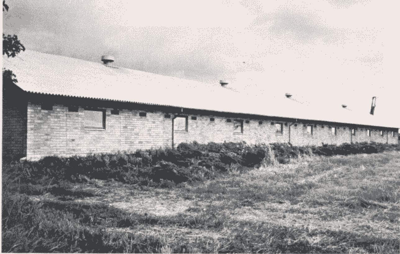
Ydermuren af Lamelteglelementer opbygget af teglfulblokke.
