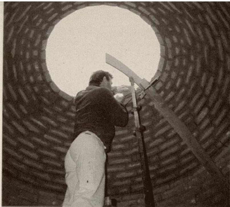
Kuppelpasseren i brug.
