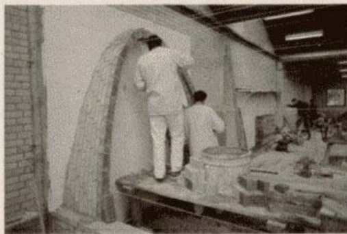
Opmuring af hvælv på Teknisk Skole i Slagelse
