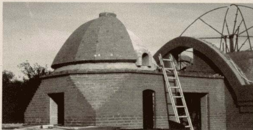
Kuplen afdækkes med Rockwool, der pudses med fiberbeton.
